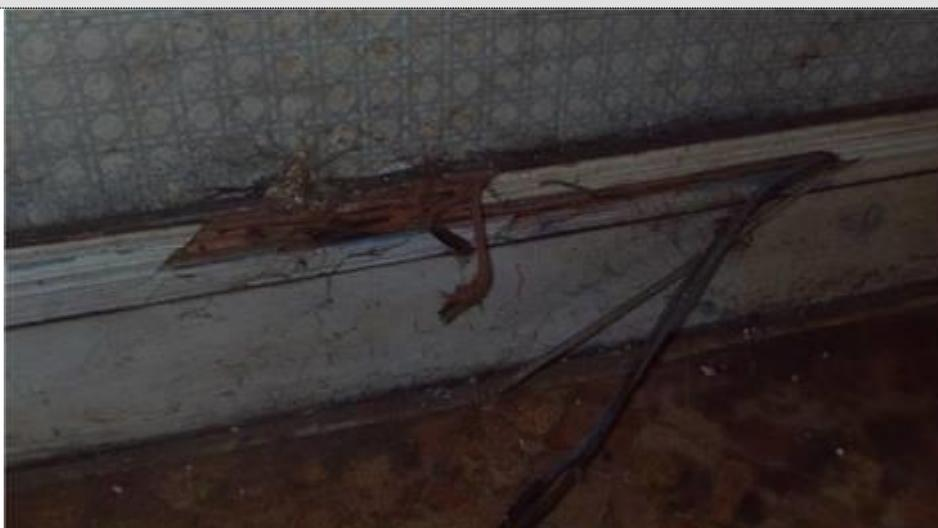
Description : Au moins un CONDUCTEUR isolé n'est pas placé sur toute sa longueur dans un conduit, une goulotte, une plinthe ou une huisserie, en matière isolante ou métallique, jusqu'à sa pénétration dans le MATERIEL ELECTRIQUE qu'il alimente.
