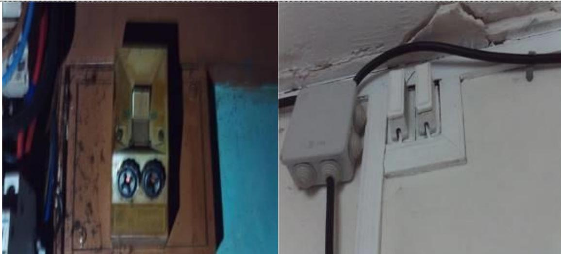
**Description :** Le type d'au moins un FUSIBLE ou un DISJONCTEUR n'est plus autorisé (fusible à tabatière, à broches rechargeables, COUPE-CIRCUIT A FUSIBLE de type industriel, DISJONCTEUR réglable en courant protégeant des CIRCUITS terminaux).
