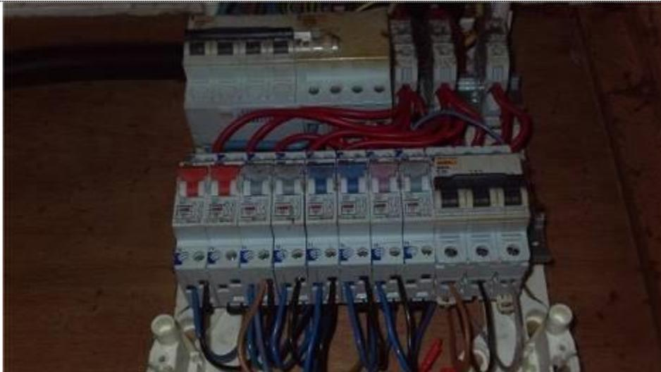
**Description :** Au moins un dispositif de PROTECTION CONTRE LES SURINTENSITES n'est pas placé sur un CONDUCTEUR de phase.
